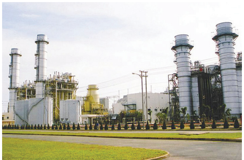
Nhà máy nhiệt điện Phú Mỹ
